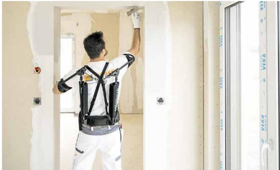
Eine echte Hilfe: Exoskelette unterstützen Mitarbeiterinnen und Mitarbeiter bei körperlich anstrengenden Tätigkeiten, beispielsweise bei Arbeiten, die über Kopf ausgeführt werden. Foto: Ottobock Industrials
