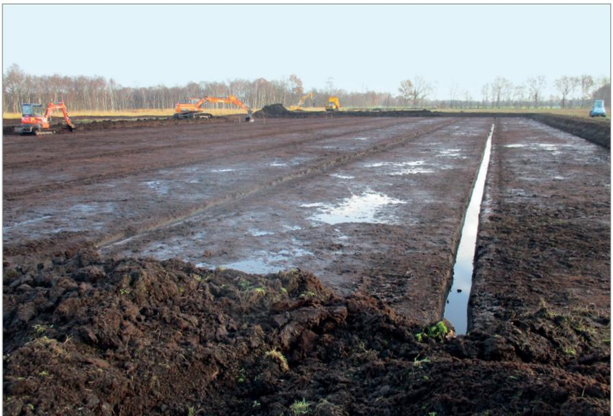
Abb. 3: Bodenabtrag zur Einrichtung des Anzuchtpolders auf ehemaligem Hochmoorgrünland.
