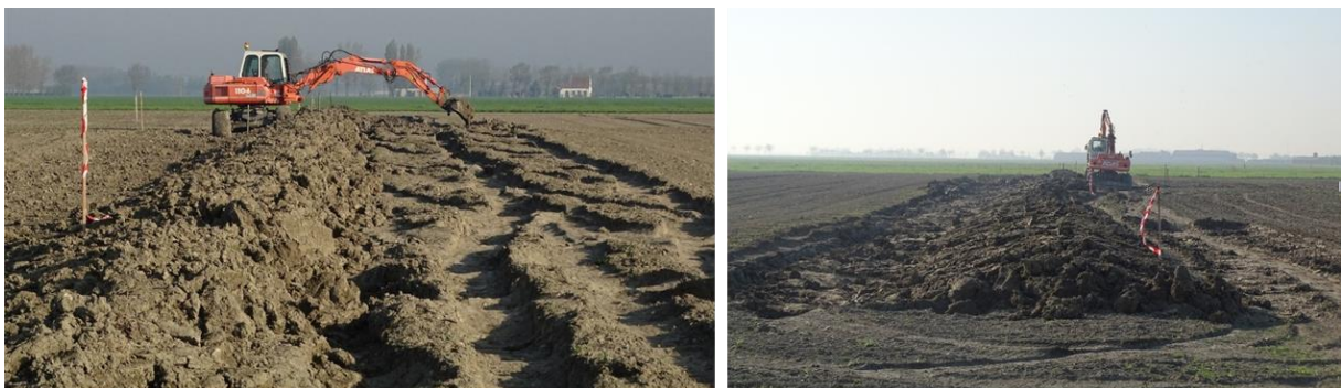
Figuur 6. Aanleg keverbank Ramskapelle met kraan
