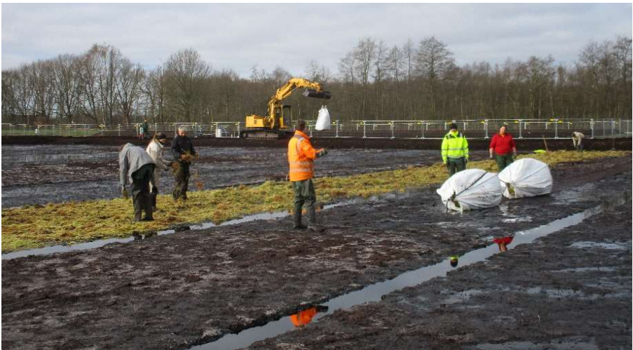
Aanleg van een proefboerderij met veenmos bij de stad Baver in Nedersaksen, Duitsland.
